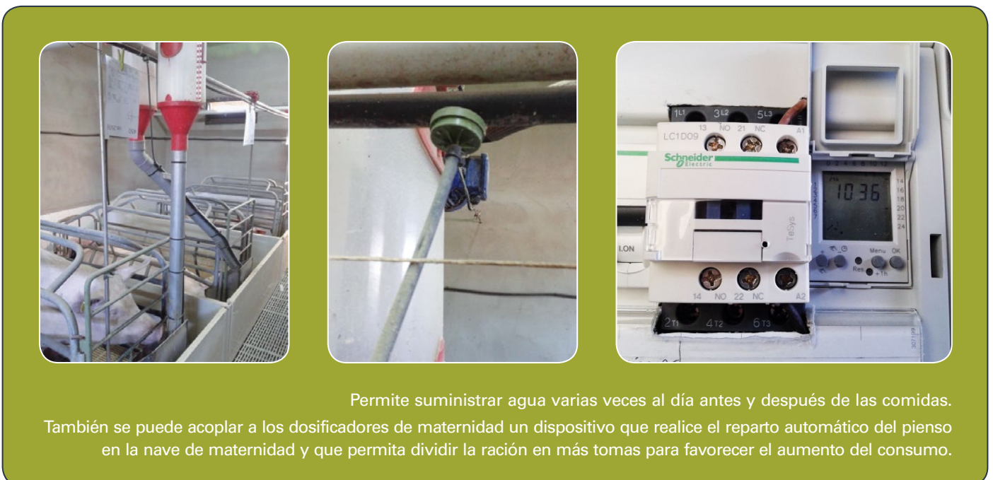
Figura 9. Sistema de aporte extra de agua en maternidad con temporizador.
